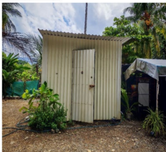
Estructura 1-Tipo bodega
