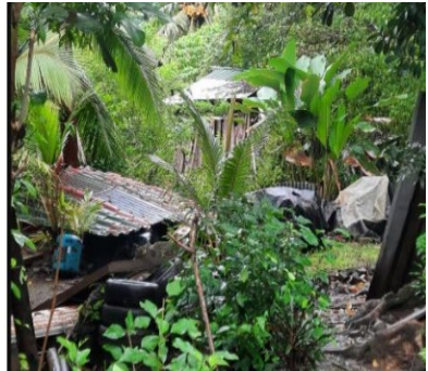
Construcciones en ZMT
