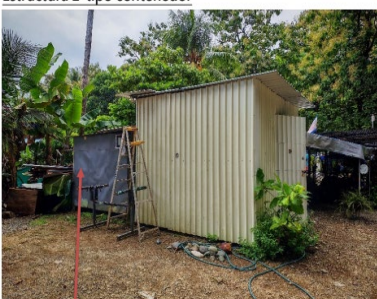
Estructura 2-tipo contenedor
