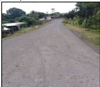
Foto 4 Pavimentación con carpeta asfáltica
