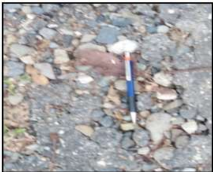
Fotografía 3: Se observó base con material de río.
