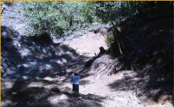
Punta Achiote, Febrero 2007 Destrucción de manantial
