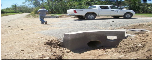
Entrada principal y paso de alcantarilla
